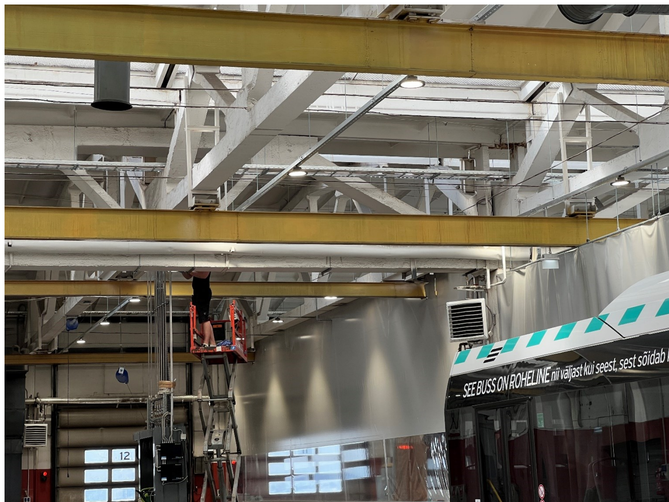
Pilt 14: Peterburi tee 73 töökoda. Liinide nr. 1 ja 2 kohal olevad laekonstruktsioonid.
