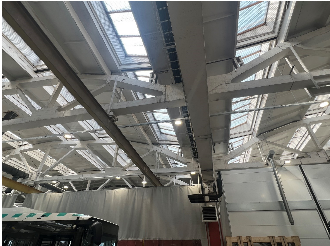
Pilt 13: Peterburi tee 73 töökoda. Liinide nr. 1 ja 2 kohal olevad laekonstruktsioonid.
