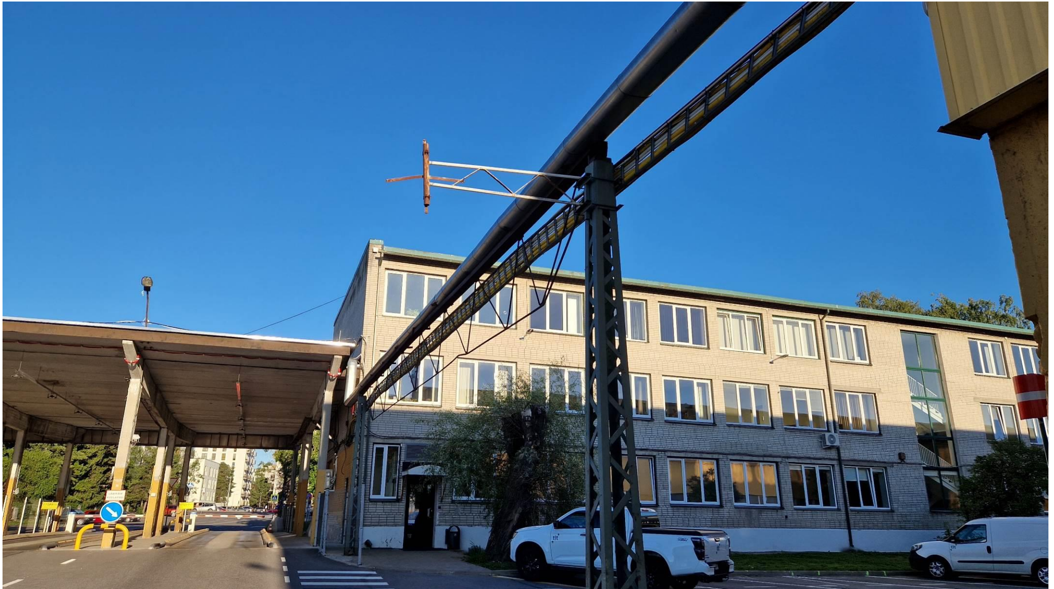
Foto nr 24: Vaade pääslahoone trassile. Pildil allesjääv lõik, töökojahoone nurk pildi paremal ülanurgas.
