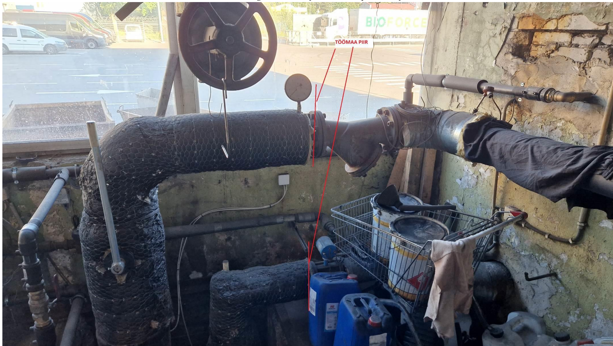
Foto nr 4: Vaade hoonesse sisenevale küttrassile. Trassil on märgitud töömaa piirid. Piirist paremale jääv torustik läheb likvideerimisele.
