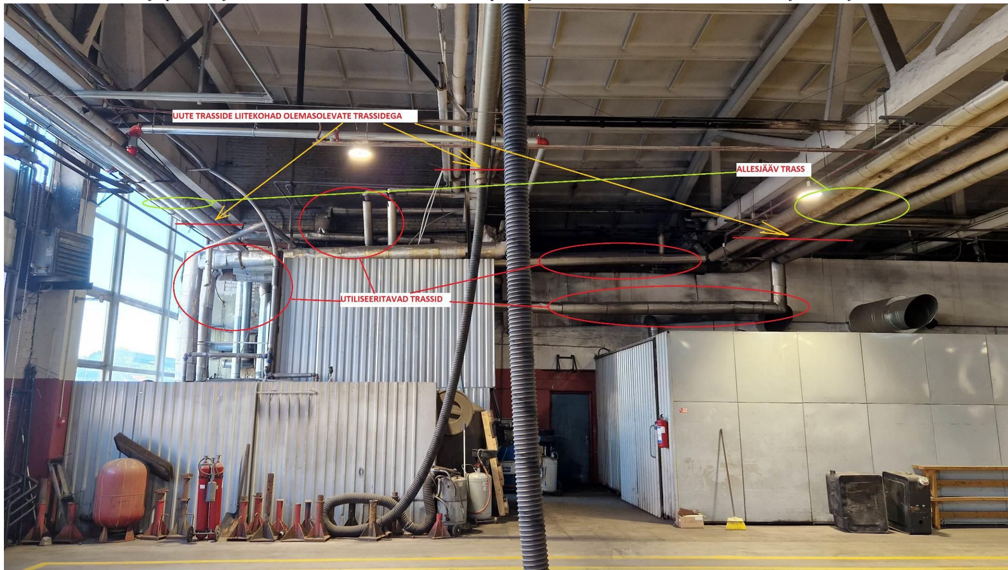
Foto nr 2: Vaade töökoja poolt soojussõlmele. Vaatel on näha tööde teostuse piirid ja eemaldatavad kütetrassid vahetult soojussõlme juures.
