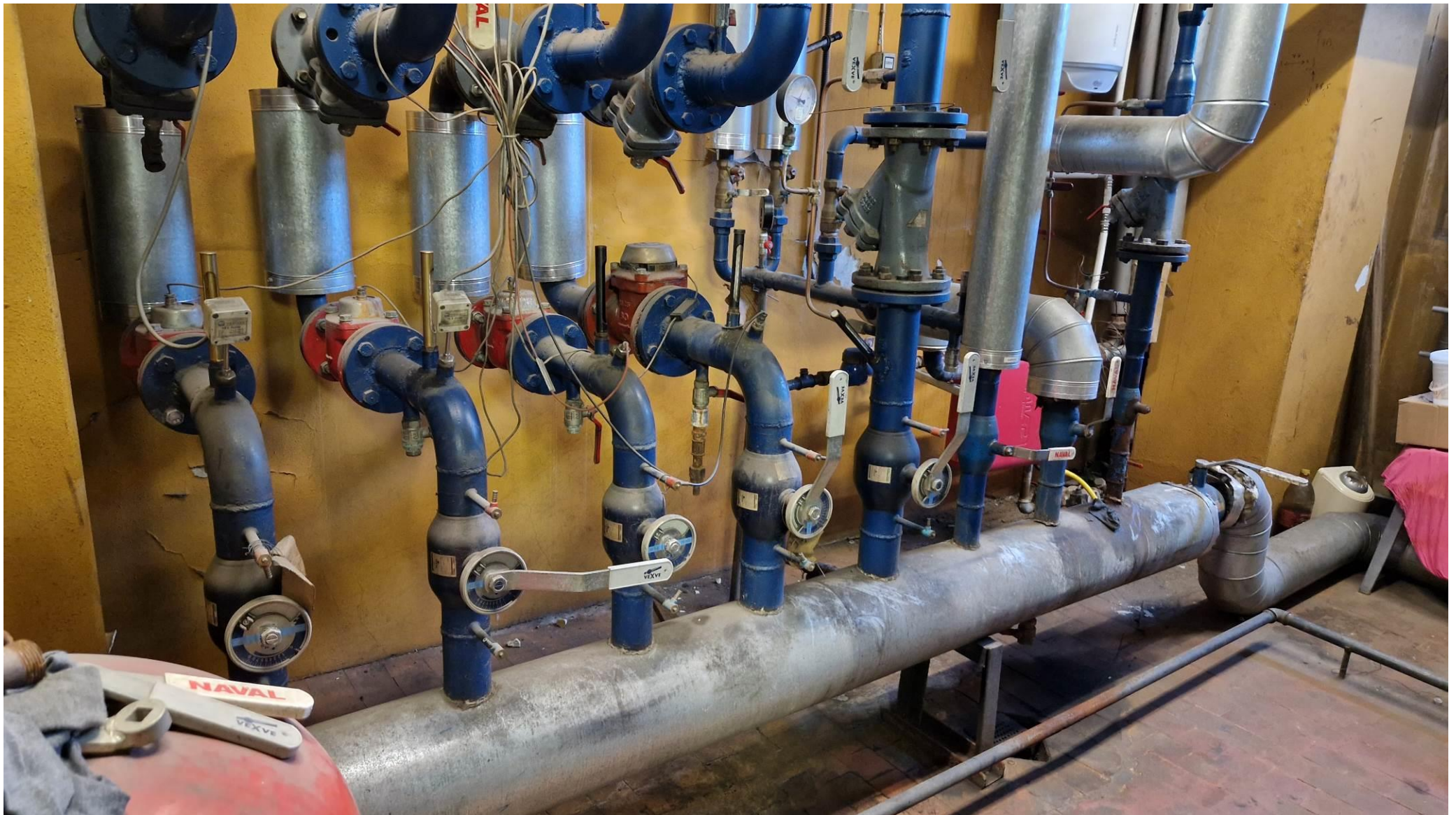
Foto nr 6: Vaade soojussõlmest. Vaatel on näha tööde likvideeritav kollektor.
