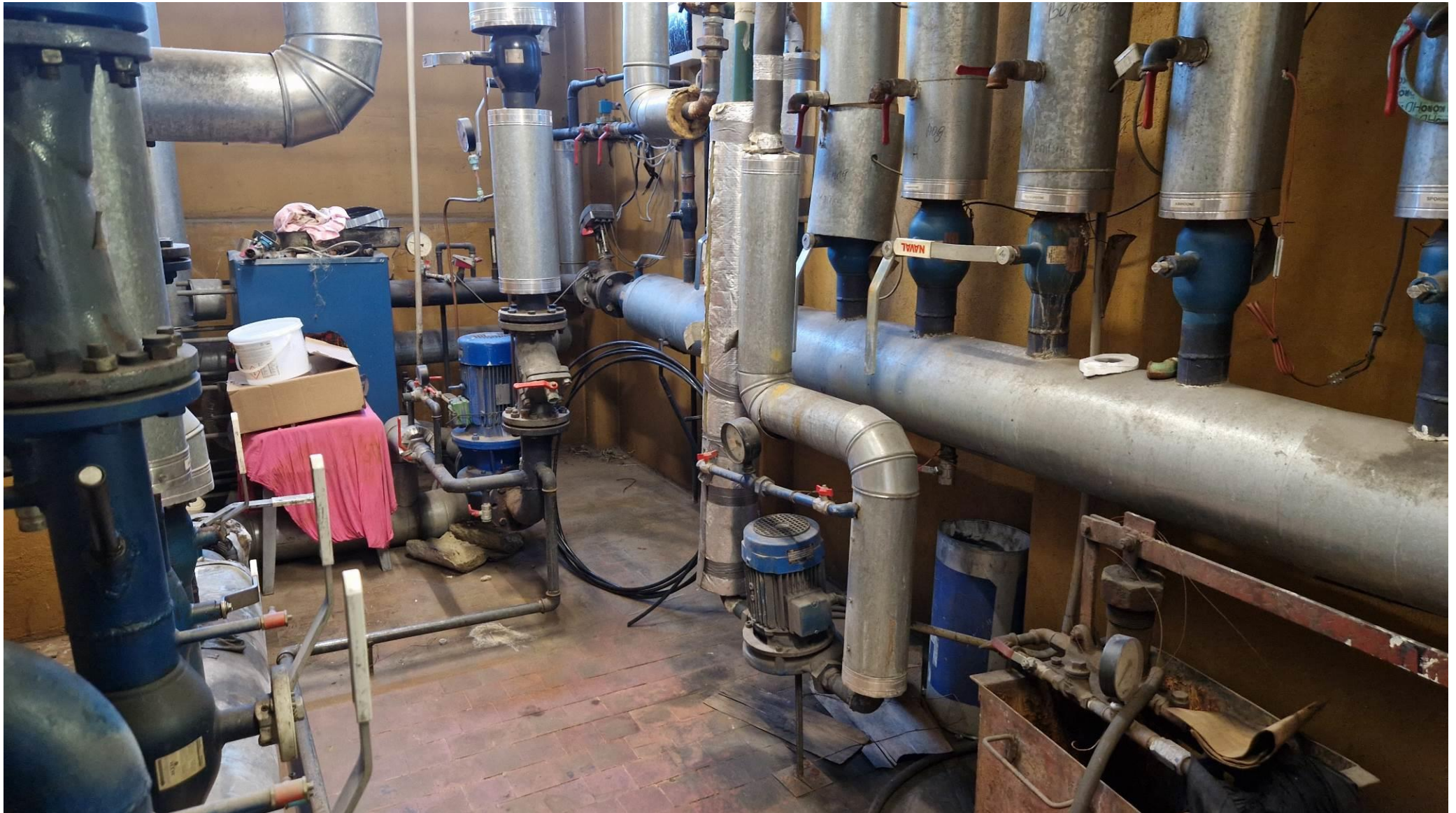
Foto nr 7: Vaade soojussõlmest. Vaatel on näha tööde likvideeritav kollektor.
