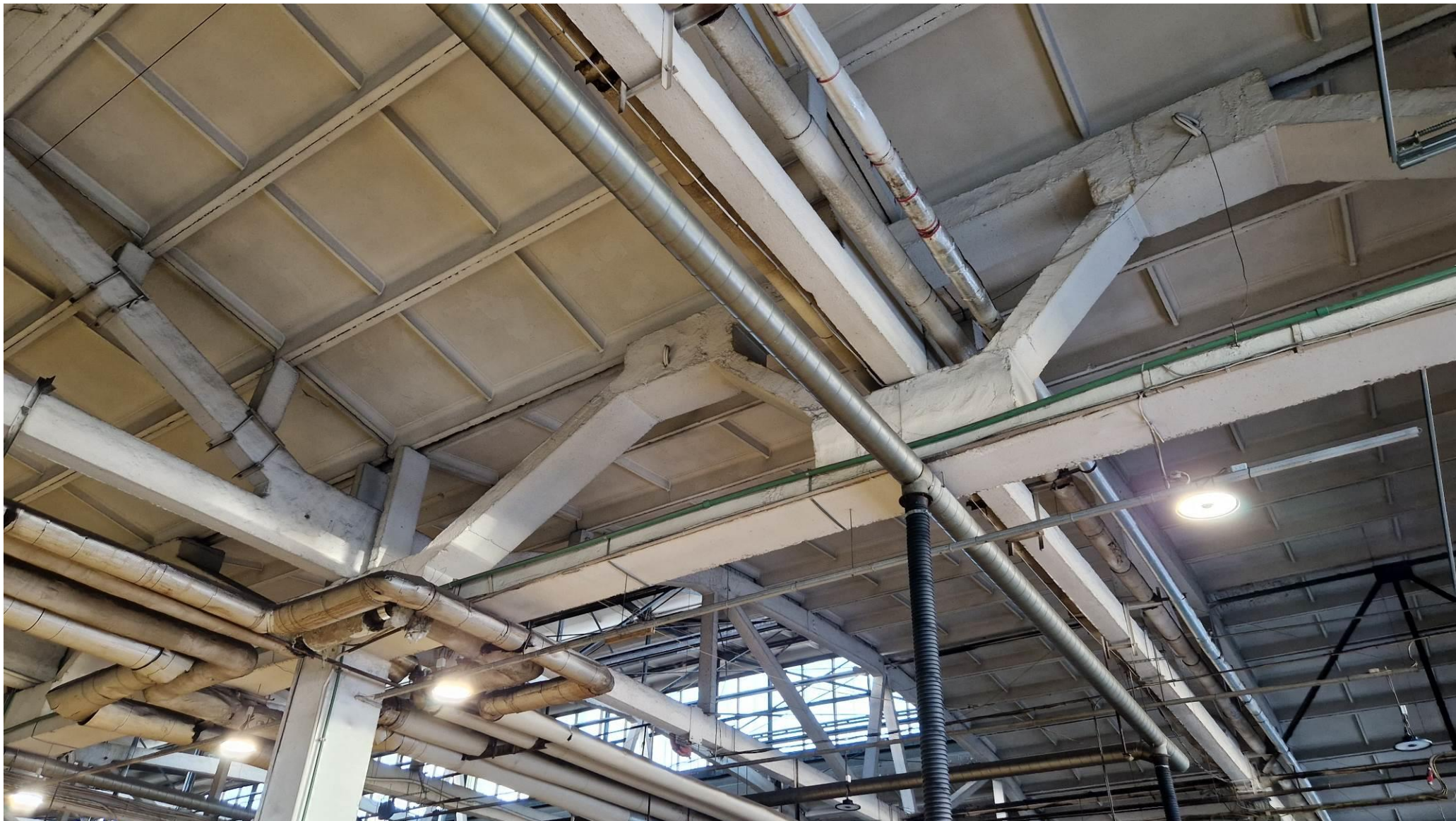
Foto nr 9: Vaade fermidele. Vaatel on näha iseloomulikke fermide liitumissõlmed.
